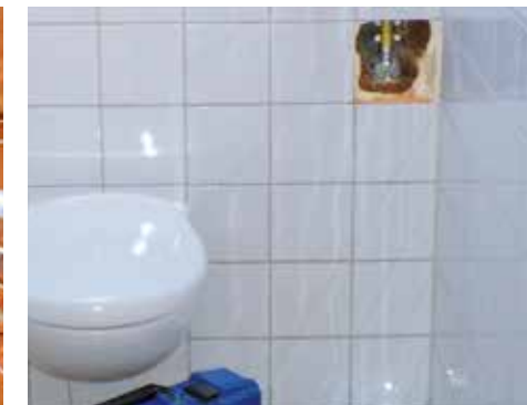
Zerstörungsfreie Fliesenentfernung
