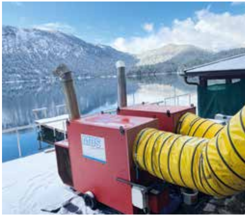
Links: Blick auf das im Umbau befindliche Eibsee-Hotel
