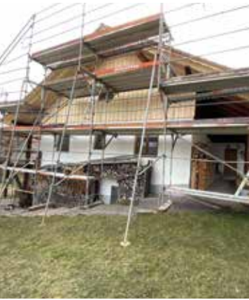
Erneuerung der Holzverschalung an der Giebelseite
