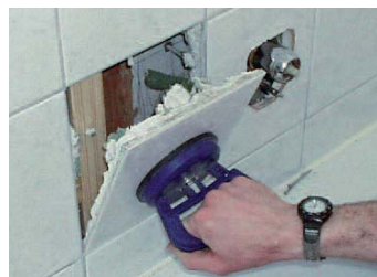
Fliesen werden bei MBS beschädigungsfrei entfernt und können nach der Schadenbehebung problemlos wieder eingesetzt werden.
