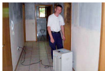
Trocknung und Geruchsneutralisierung.
