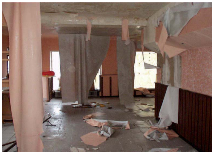
Ein großer Wasserschaden, alle relevanten Maßnahmen, von der Leckortung bis zur Sanierung sind hier gefragt.
