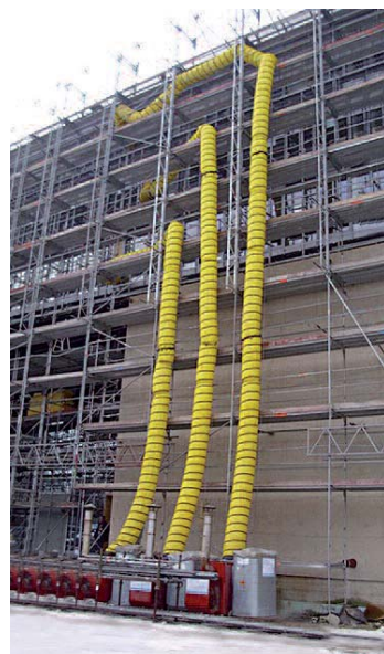
MBS Baubeheizungssystem mit Heizschläuchen über mehrere Etagen
