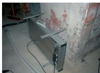
Bild oben: Flachdachtrocknung mittels Druck-Vakuum-Verfahren. Bild unten: Kommunwandtrocknung, durch Luftzirkulation über Kernbohrungen.
