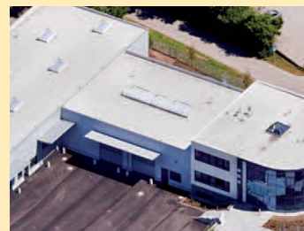
Der Gebäudetrakt des neuen MBS Ausbildungs- und Schulungszentrums.
