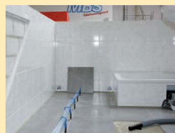
Dämmschicht-Trocknung mittels schonender Fliesenkreuzmethode und gut erkennbar, die zerstörungsfreie Fliesenentfernung.
