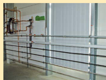
Unterschiedlicher materialspezifischer Aufbau von Rohrleitungssystemen.
