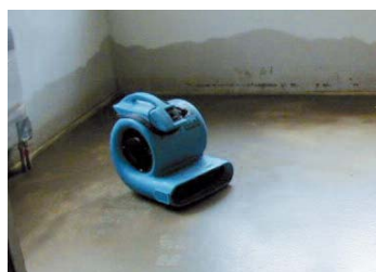
Bild oben: Großbaustellentrocknung durch MBS Heizsysteme über mehrere Etagen. Bild unten: Raumtrocknung mittels MBS Turbo-Gebläse.
