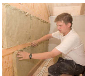
Dämmschichten, Fliesen- oder Fußbodenbeläge werden komplett wieder hergestellt.
