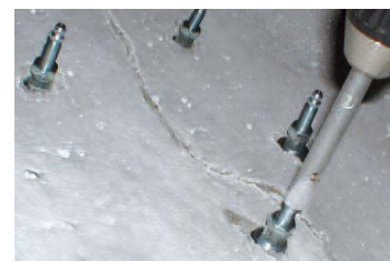
Verspannen des Schraubpackers
