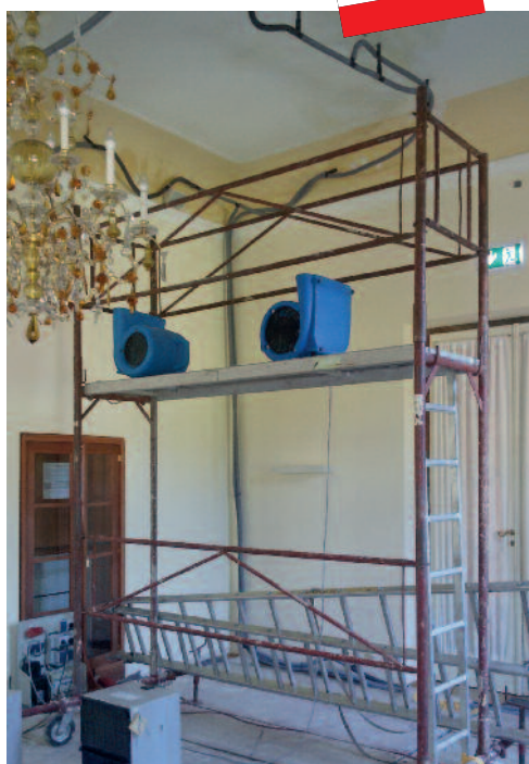
Von MBS installierte Trockner und Belüftungsschläuche, die historischen Holzböden wurden fachmännisch abgedeckt.
