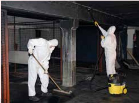
Tiefgarage: Reinigen der Gebäudeoberflächen zur Korrosionsvermeidung
