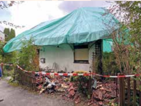
Notsicherung der Dachhaut...
